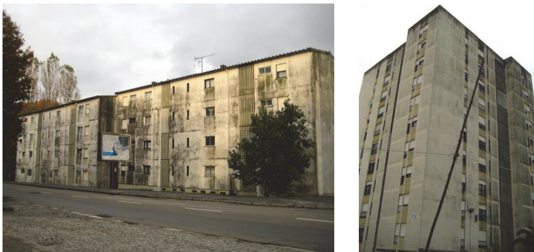
FIGURAS 22 E 23 | VISTA DA DEGRADAÇÃO GENERALIZADA DA ENVOLVENTE EXTERIOR DOS EDIFÍCIOS DO BAIRRO DO SOBREIRO
