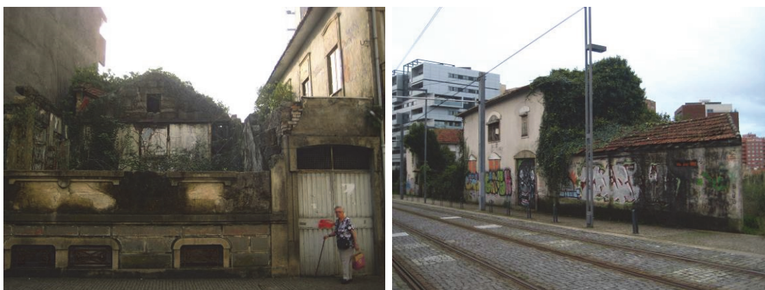
FIGURAS 20 E 21 | EXEMPLOS DE EDIFÍCIOS EM RUÍNA. À ESQUERDA, NA RUA AUGUSTO SIMÕES - À DIREITA, JUNTO À ROTUNDA DA LINHA DO METRO / N14 / RUA DONA DEOLINDA DUARTE DOS SANTOS
