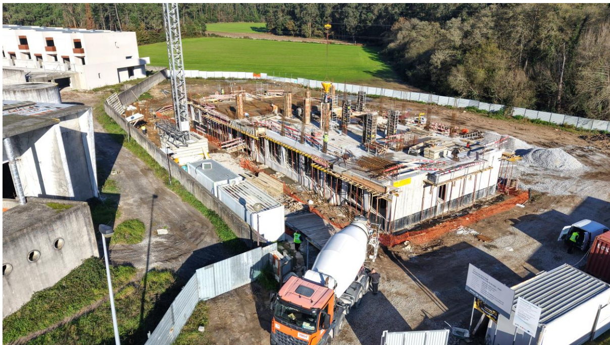
Operação na Rua Nova da Ribela, Castelo da Maia, novembro 2025
