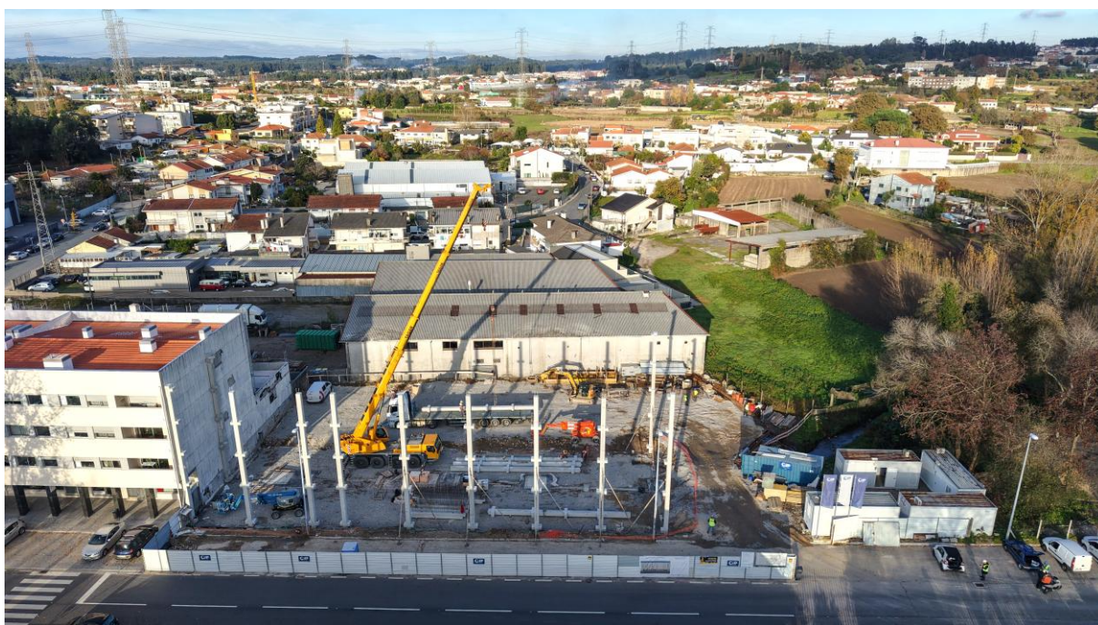
Operação na Rua Eusébio da Silva Ferreira, Nogueira, novembro 2025
