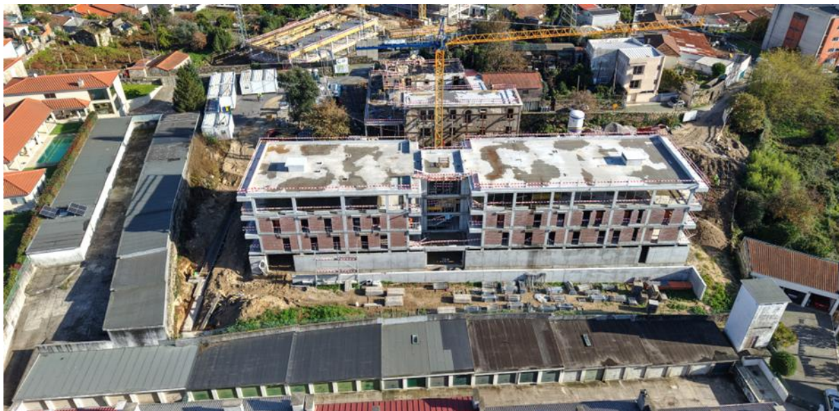
Operação correspondente ao Lote 1 da Rua Alvarim Vieira, Águas Santas, novembro 2025
