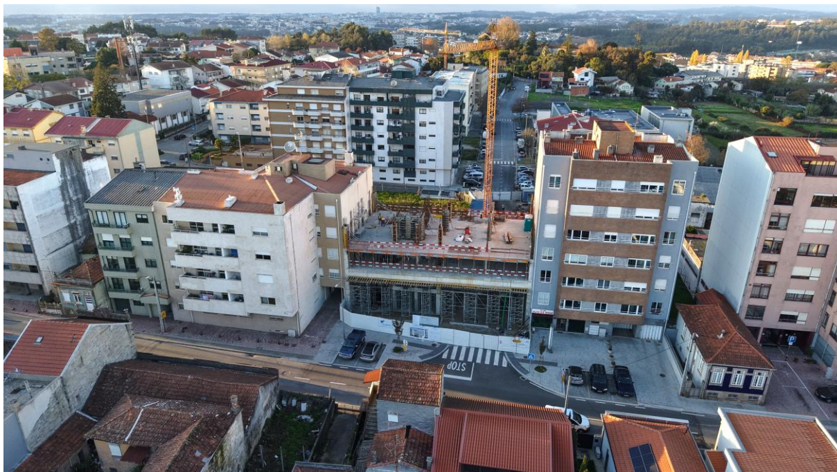
Operação na Rua D. Afonso Henriques, Águas Santas, novembro 2025
