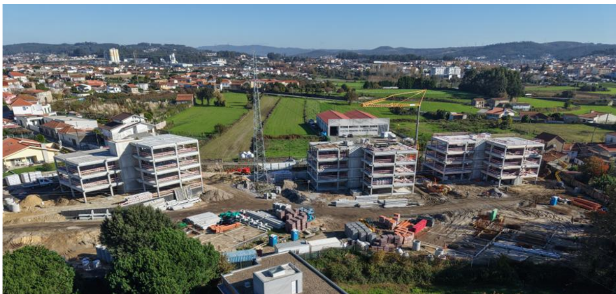
Operação na Rua Central de Ardegães, Águas Santas, novembro 2025
