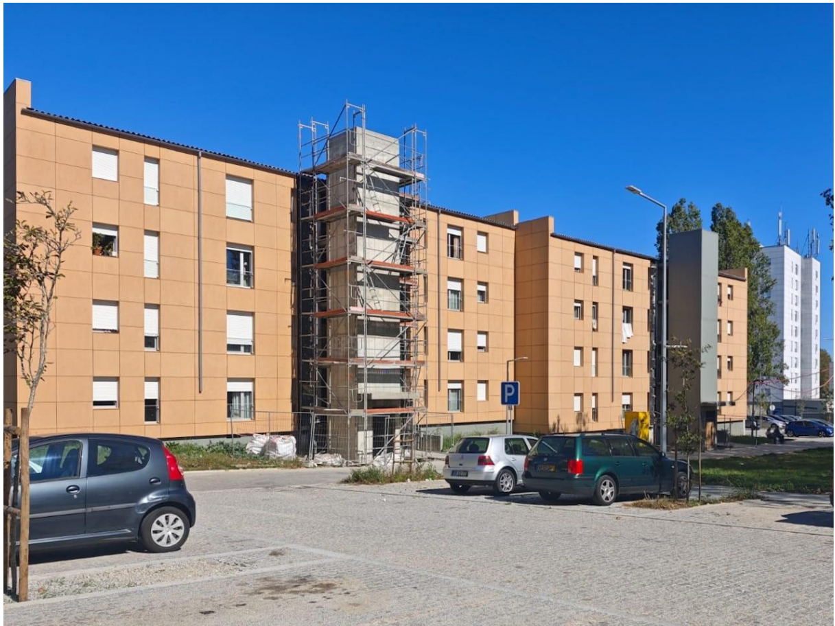
Blocos 41 e 42, Empreendimento do Sobreiro, outubro 2025
