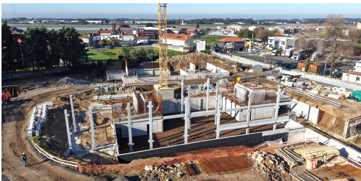
Operação na Rua da Prosela, Vila Nova da Telha, novembro 2025
