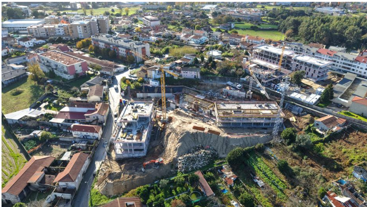
Operação na Rua Joaquim Carvalho da Costa, Águas Santas, novembro 2025
