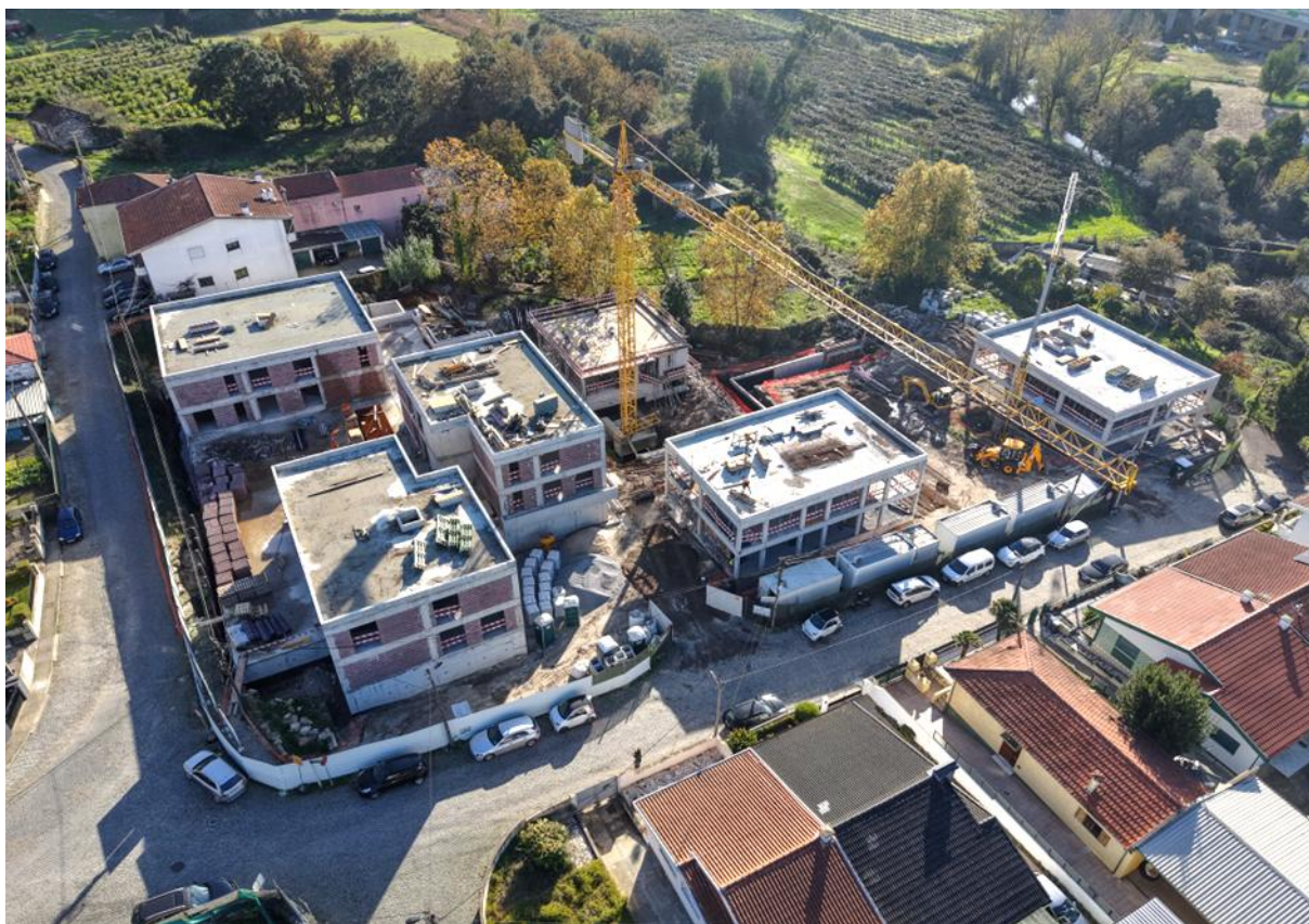
Operação na Travessa do Pisão, Águas Santas, novembro 2025
