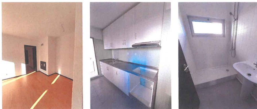
Fotografias das obras de reabilitação do Bloco 38 – Alameda das Tílias, Maia
