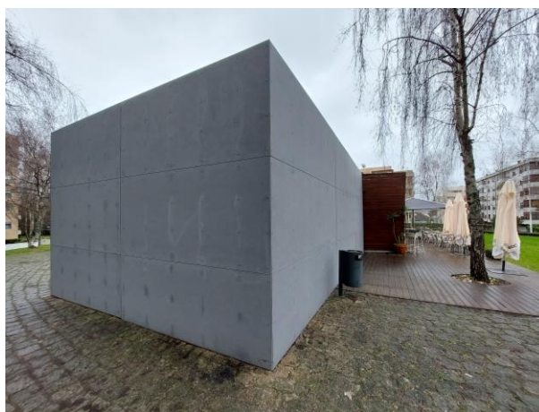
Esplanada dos Altos - Substituição de revestimentos em Viroc – fachada ventilada
