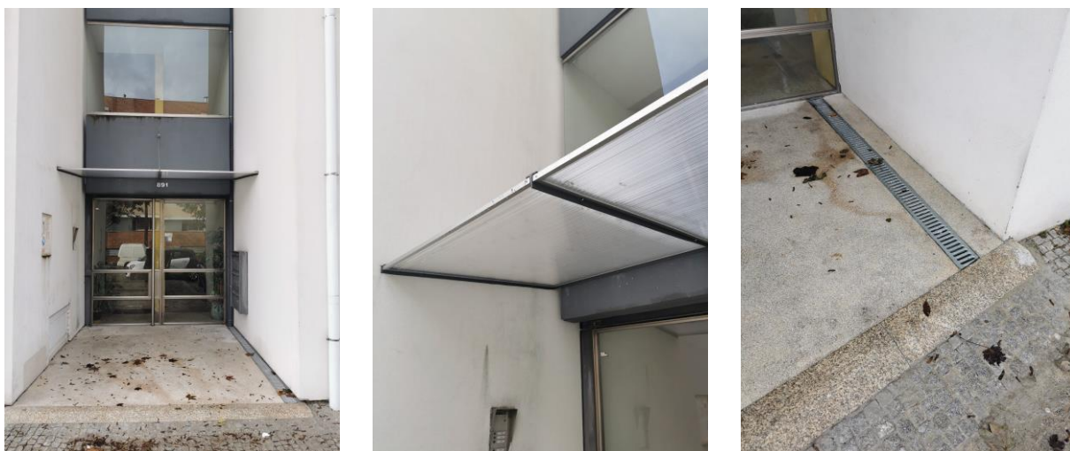
Reabilitação das entradas do Empreendimento de António Simões, Águas Santas (sistemas de drenagem de águas pluviais e aplicação de alpendres)
