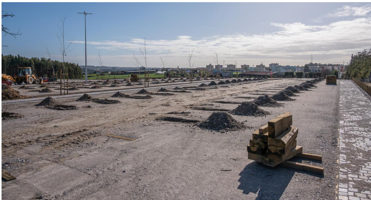
Construção de parque de estacionamento de apoio ao TECMAIA – Ecoparque – estrutura do aparcamento em sequências perpendiculares ao arruamento de suporte (lugares assinalados com sulipas de madeira) – pavimento de tout-venant compactado, com especial atenção à drenagem natural do terreno e aos aspetos ecológicos da construção
