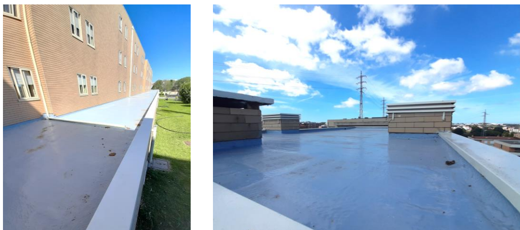
Reabilitação dos corpos emergentes e da cobertura e fachada da garagem do Empreendimento Municipal de Arroteia II
