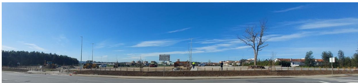
Construção de parque de estacionamento de apoio ao TECMAIA – Ecoparque
