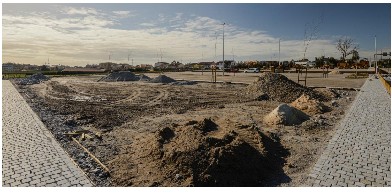
Construção de parque de estacionamento de apoio ao TECMAIA – Ecoparque – vista a partir do passeio da via principal
