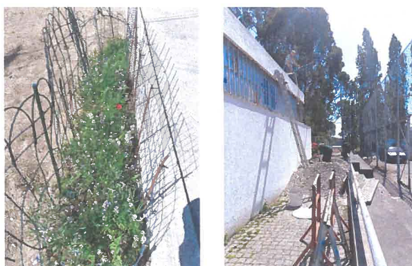
Imagens ilustrativas de canteiro plantado e apoio às obras da cobertura do edifício do polidesportivo – comunidade da Anta
