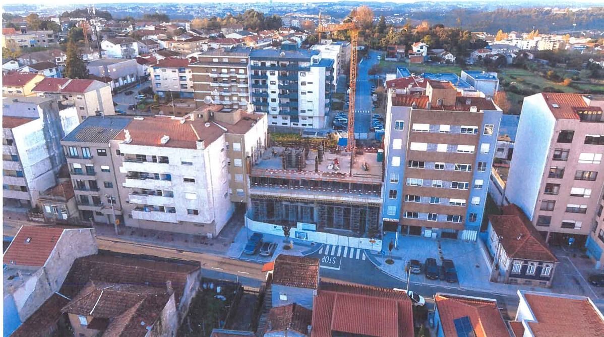
Operação na Rua D. Afonso Henriques, Águas Santas, novembro 2025
