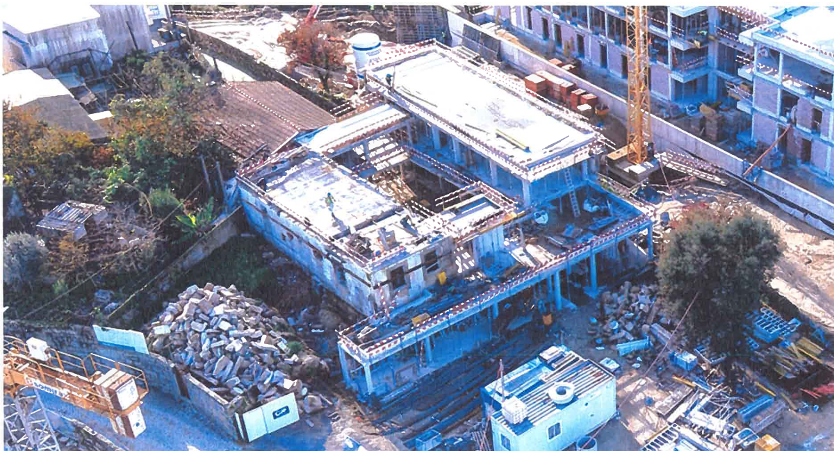
Operação correspondente ao Lote 2 da Rua Alvarim Vieira, Águas Santas, novembro 2025
