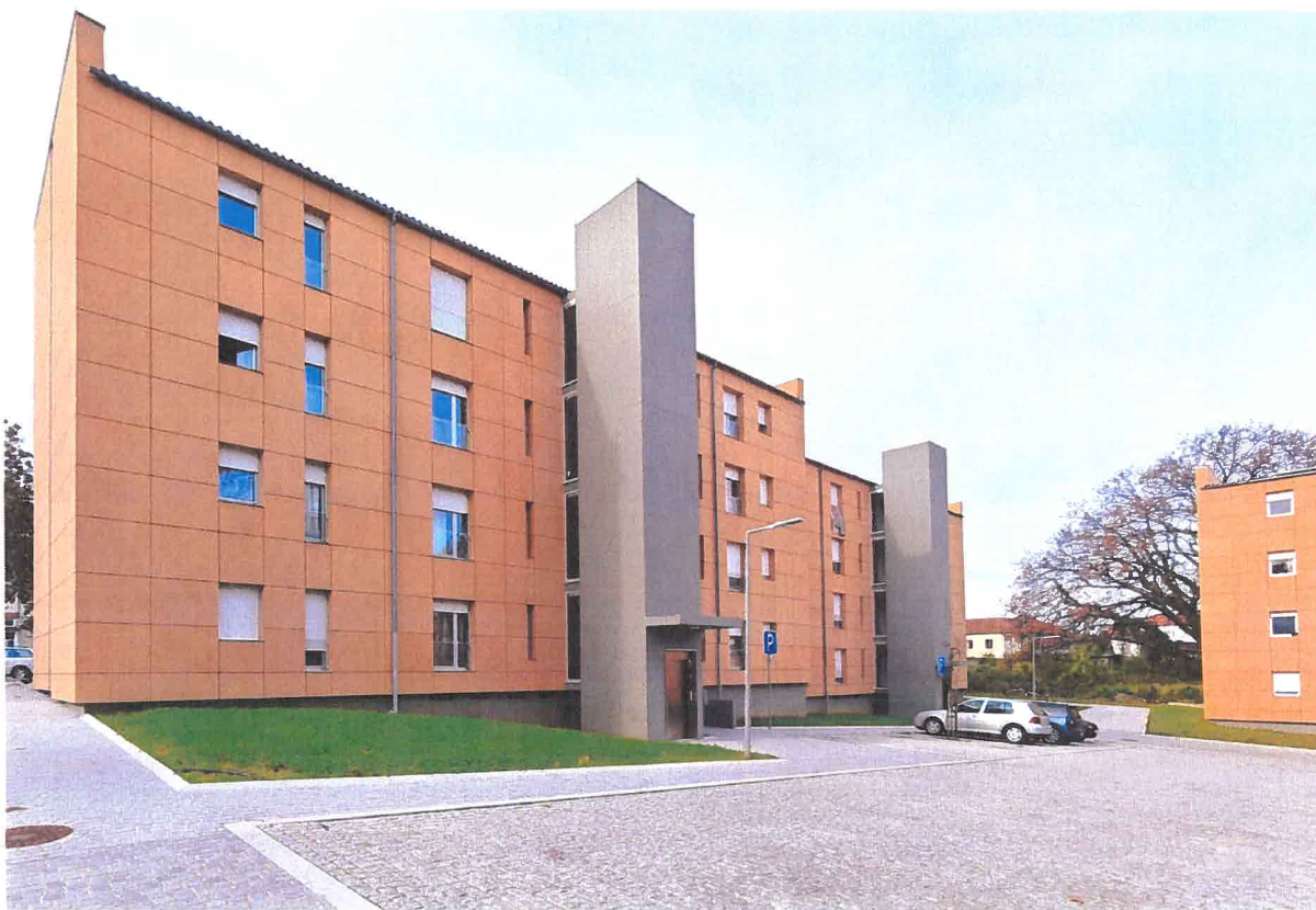
Blocos 41 e 42, Empreendimento do Sobreiro, novembro 2025
