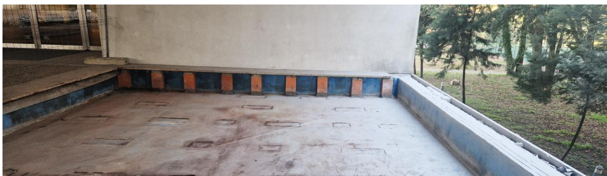
Reabilitação da zona do espelho de água preexistente no Edifício Tecmaia – área a pavimentar (extensão da praça coberta)
