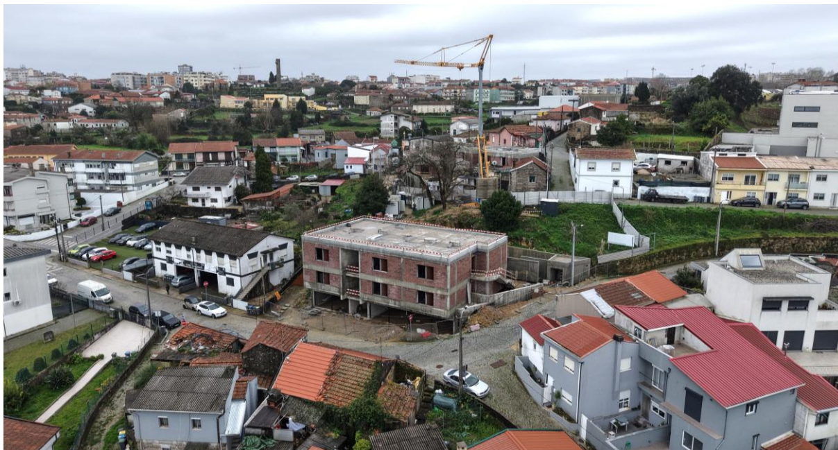
Situação da obra no início de fevereiro de 2026
