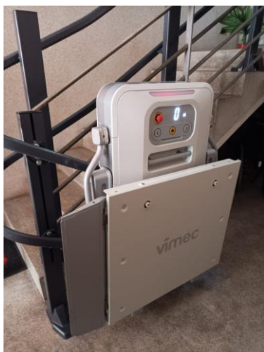
Instalação de plataforma elevatória
