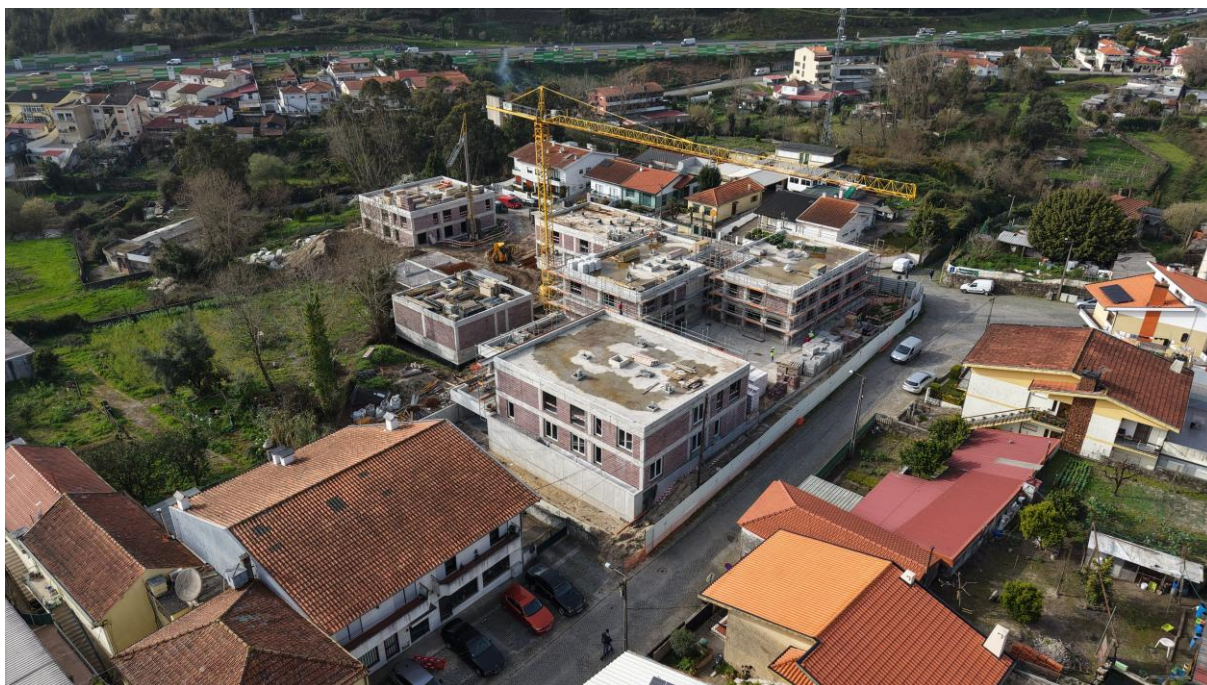
Situação da obra no início de março de 2026
