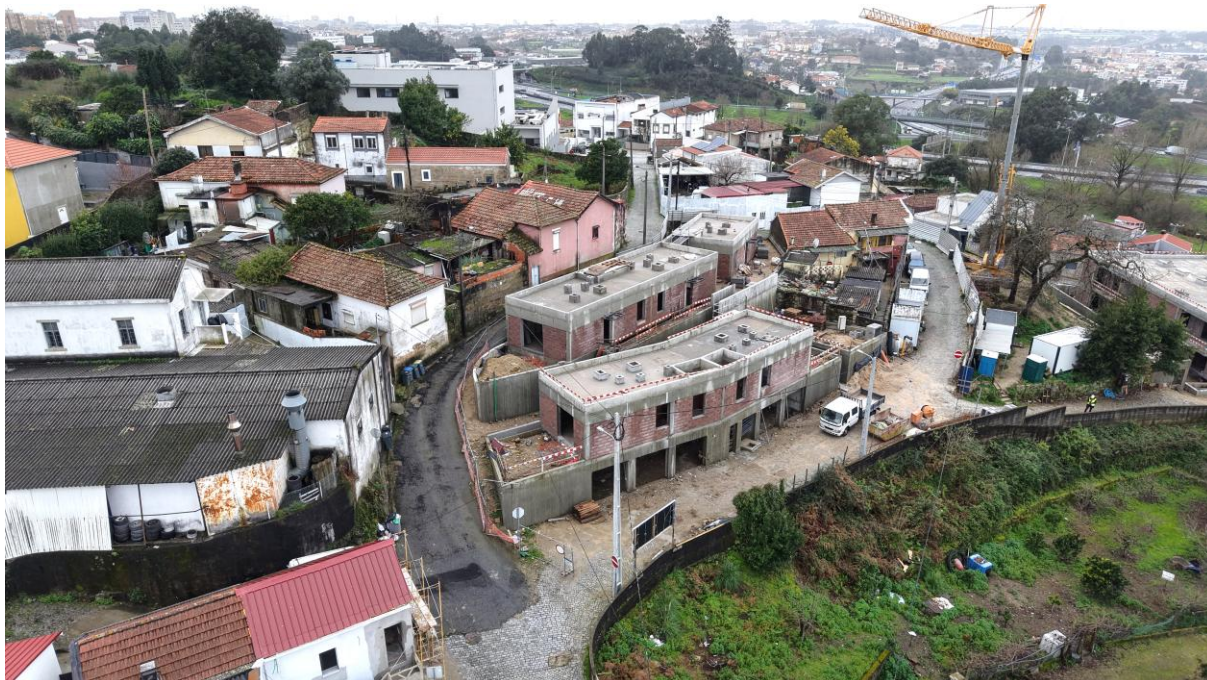
Situação da obra em fevereiro de 2026
