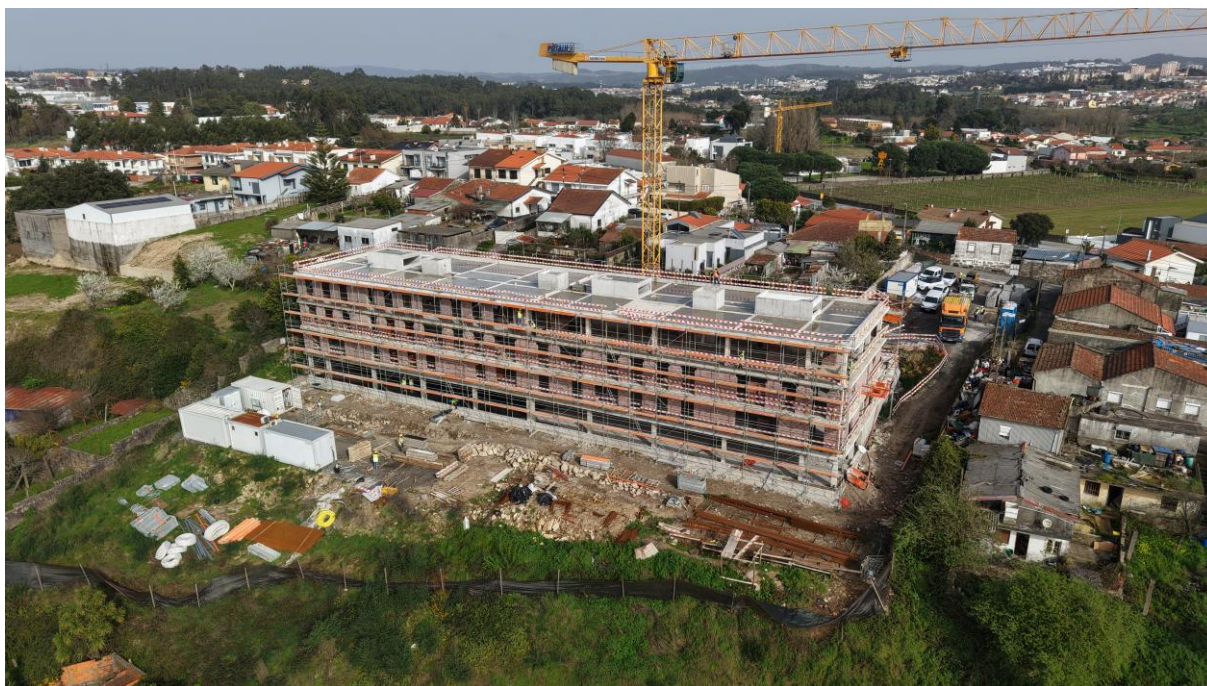
Situação da obra no início de fevereiro de 2026
