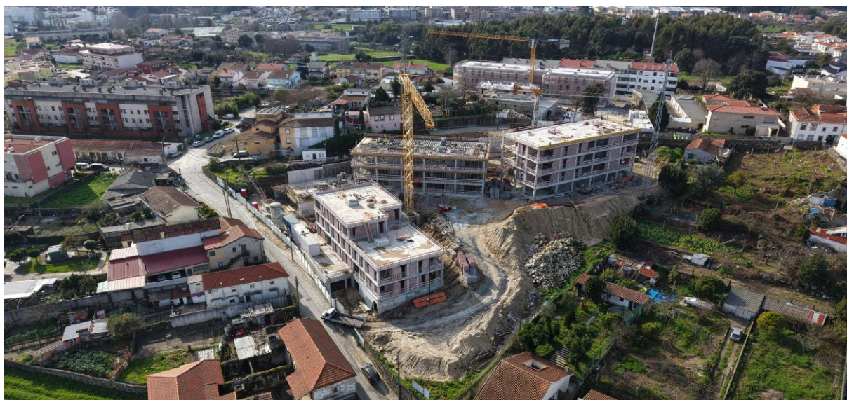
Situação da obra em final de fevereiro de 2026
