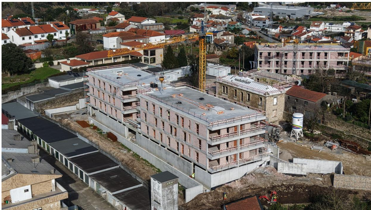
Situação da obra no final de fevereiro de 2026
