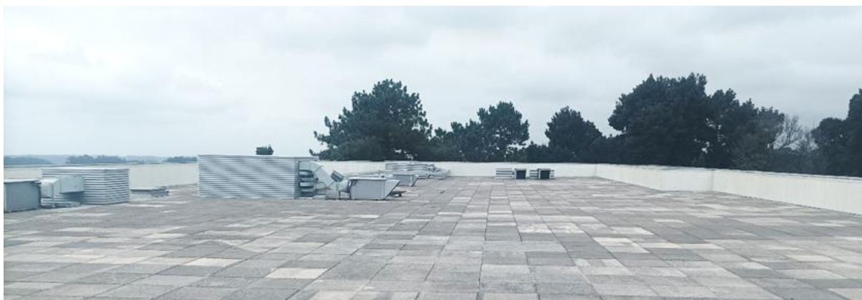
Foto da cobertura do Edifício TECMAIA, após as obras de reabilitação
