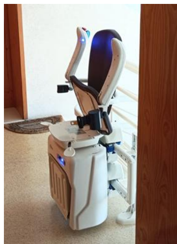
Instalação de cadeira elevatória
