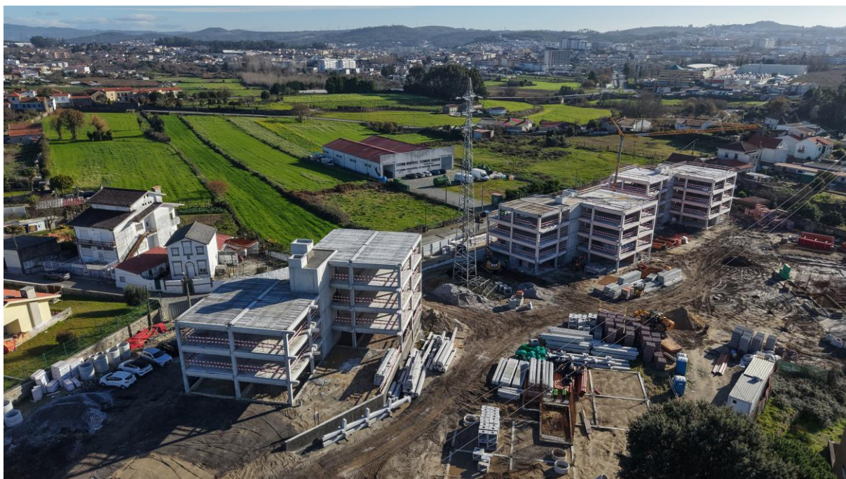
Situação da obra em janeiro de 2026
