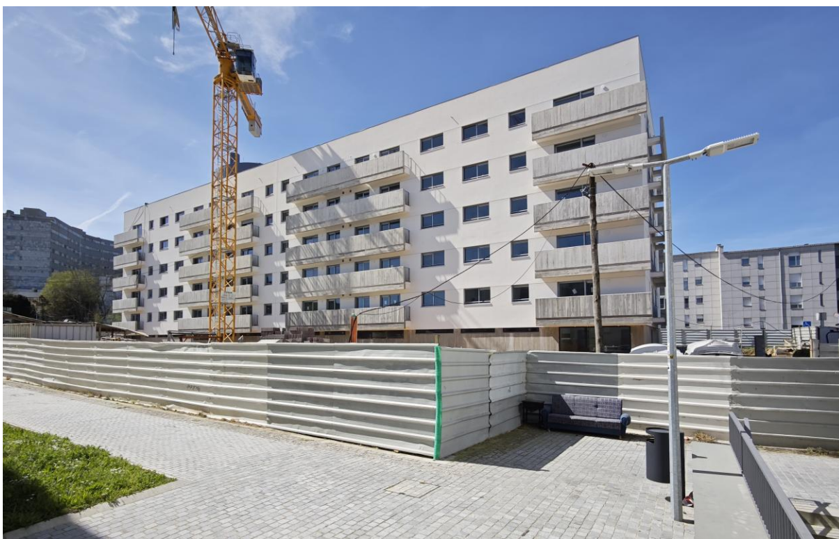
Situação da obra em fevereiro de 2026
