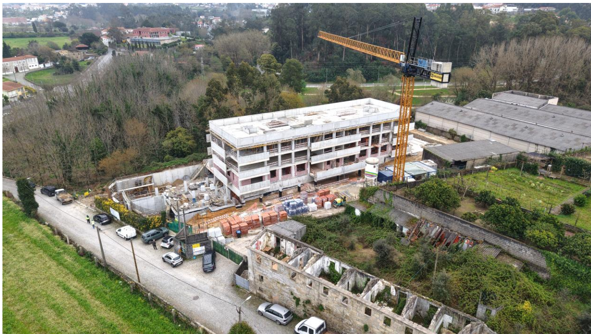
Situação da obra em meados de março de 2026
