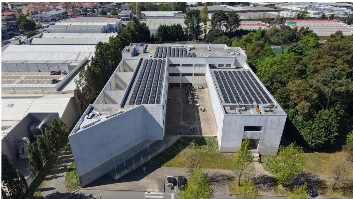
Fotografia do Edifício TECMAIA, correspondente à fase final de instalação de painéis fotovoltaicos, março 2026
