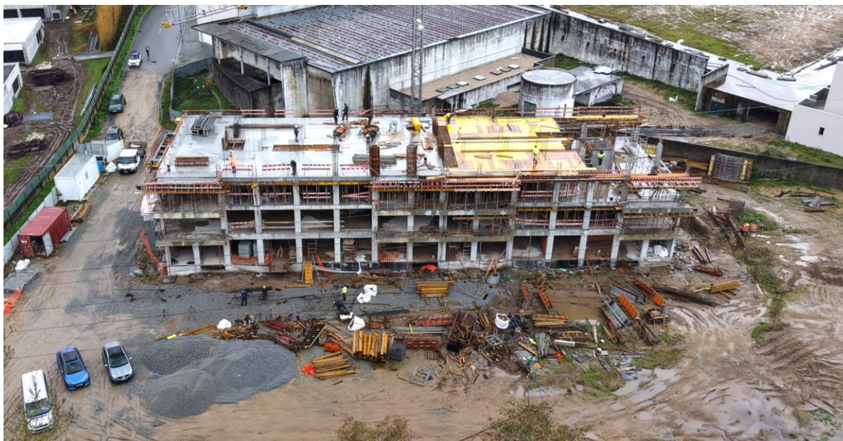
Situação da obra no início de fevereiro de 2026
