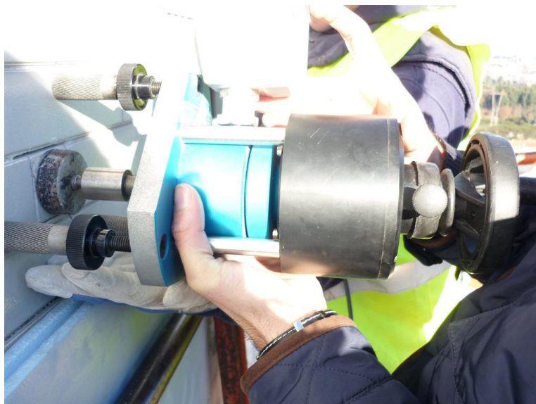
Pormenor do ensaio de arrancamento
