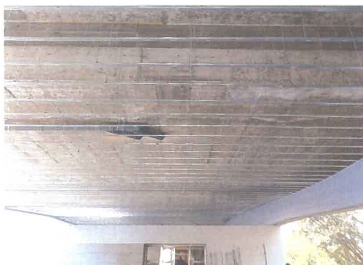
Reabilitação do teto falso da praça coberta do Edifício Tecmaia
