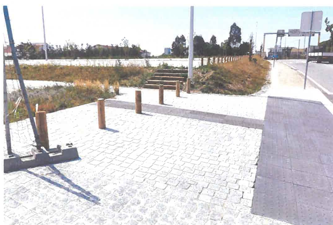
Imagem exterior do Ecoparque – vista 3 (entrada pedonal)
