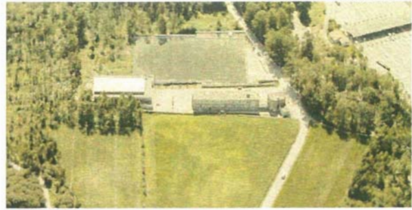
Empreendimento das Cardosas – S. Pedro de Fins
