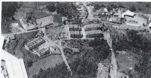
Empreendimento de Monte Vilar - Nogueira
