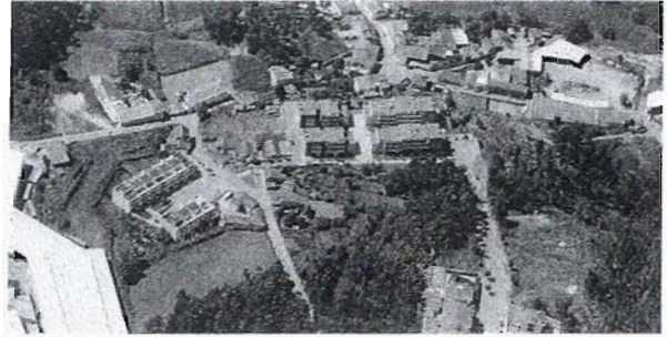
Empreendimento de Monte Vilar - Nogueira
