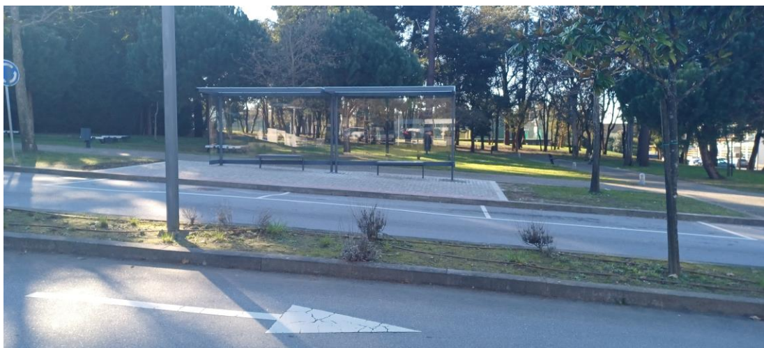
Peça desenhada de implantação da paragem de autocarro, incluindo indicação de pavimentações e registo fotográfico após execução da obra
