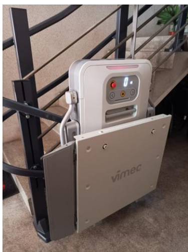
Instalação de plataforma elevatória
