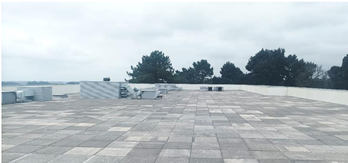
Foto da cobertura do Edifício TECMAIA, após as obras de reabilitação
