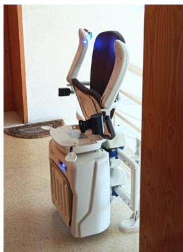
Instalação de cadeira elevatória
